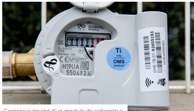
Compteur équipé d'un module de radiorelevé
