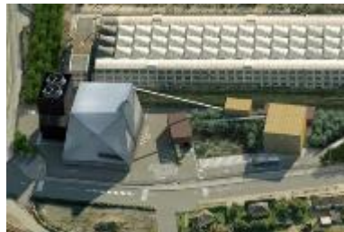
Centrale Biomasse de TOURS – en
