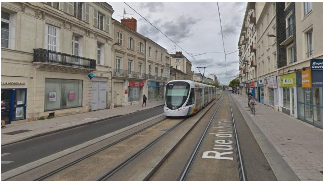
Exemple de bordure axiale entre les deux voies de tramway, tramway d'Angers
